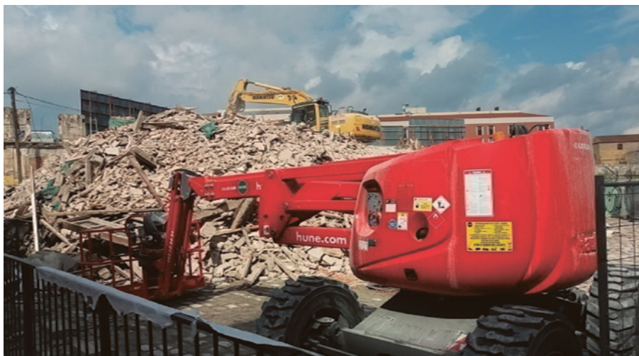
Figura 13. El lunes 1 de abril de 2019 presentaba esta imagen el solar del edificio de La Mundial, en plena demolición y retirada de materiales.
