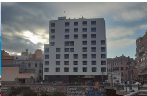
Figura 15. Fotografía tomada en junio 2022. Hotel H10.
